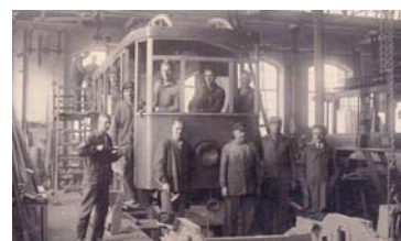
Tiek remontēti Rīgas tramvaji
